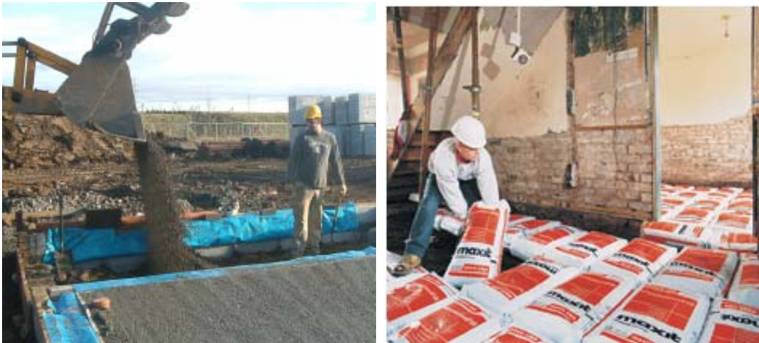
Utilização de Leca ® L no isolamento de pavimentos
