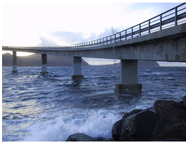
Fotografia 1 – Ponte de Runde.
